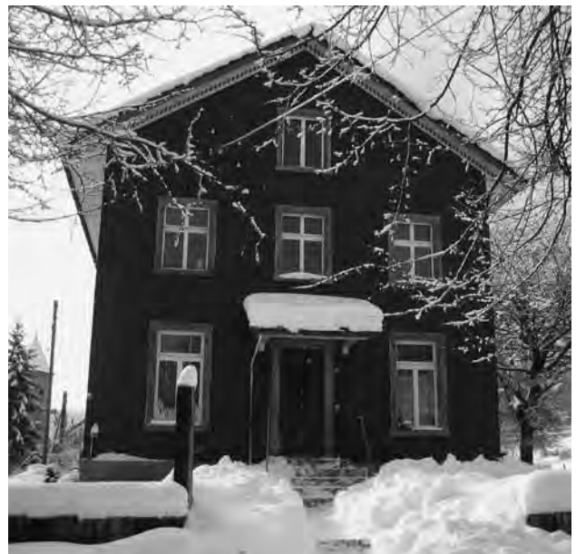
Nach der Renovation ist das alte Schulhaus mit frischer Farbe zu neuem Leben erwacht
